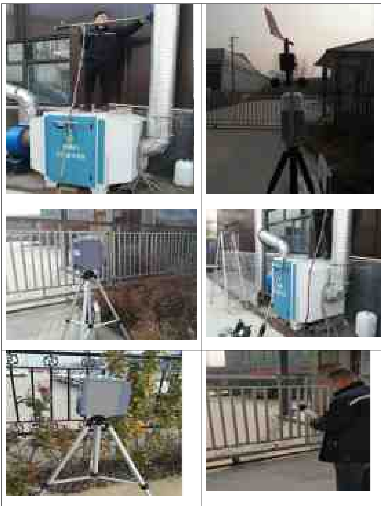
图 3：环保设备及现场采样照片
